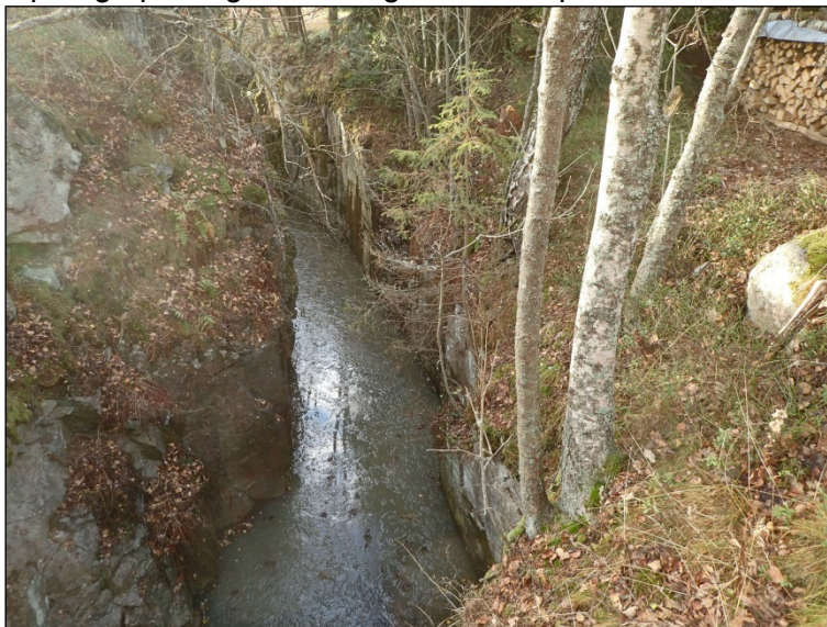
Passagen sedd mot syd.
